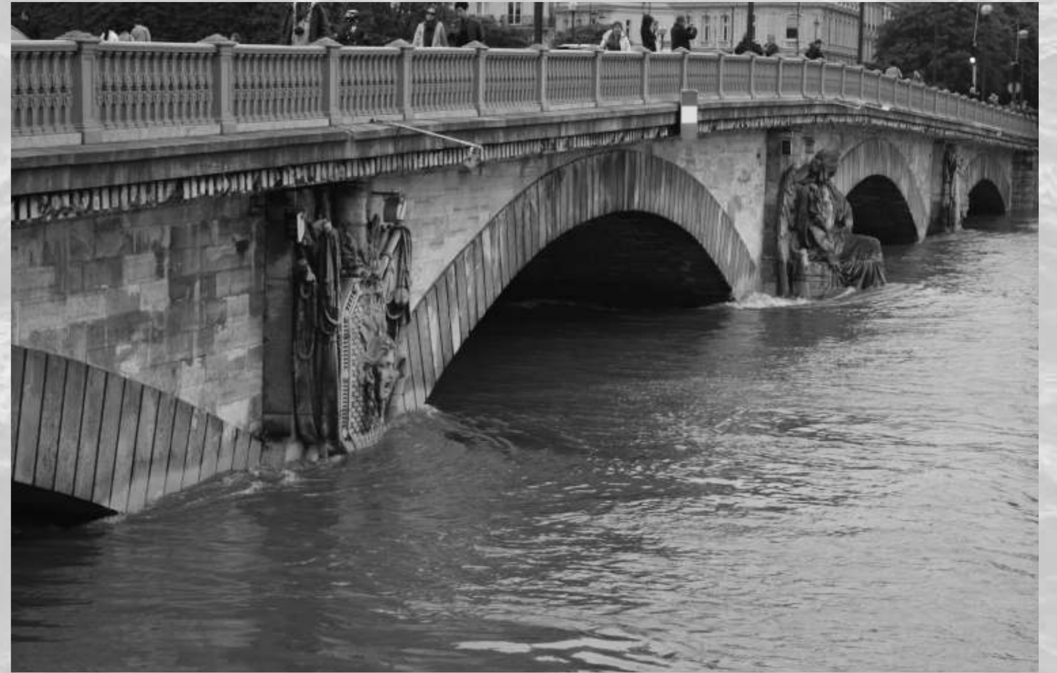
Façade amont du pont des Invalides (Paris) sur la Seine en crue, le 5 juin 2016. En surface, on observe la formation de bourrelets d'eau au niveau des piles. © F. Lachaussée
