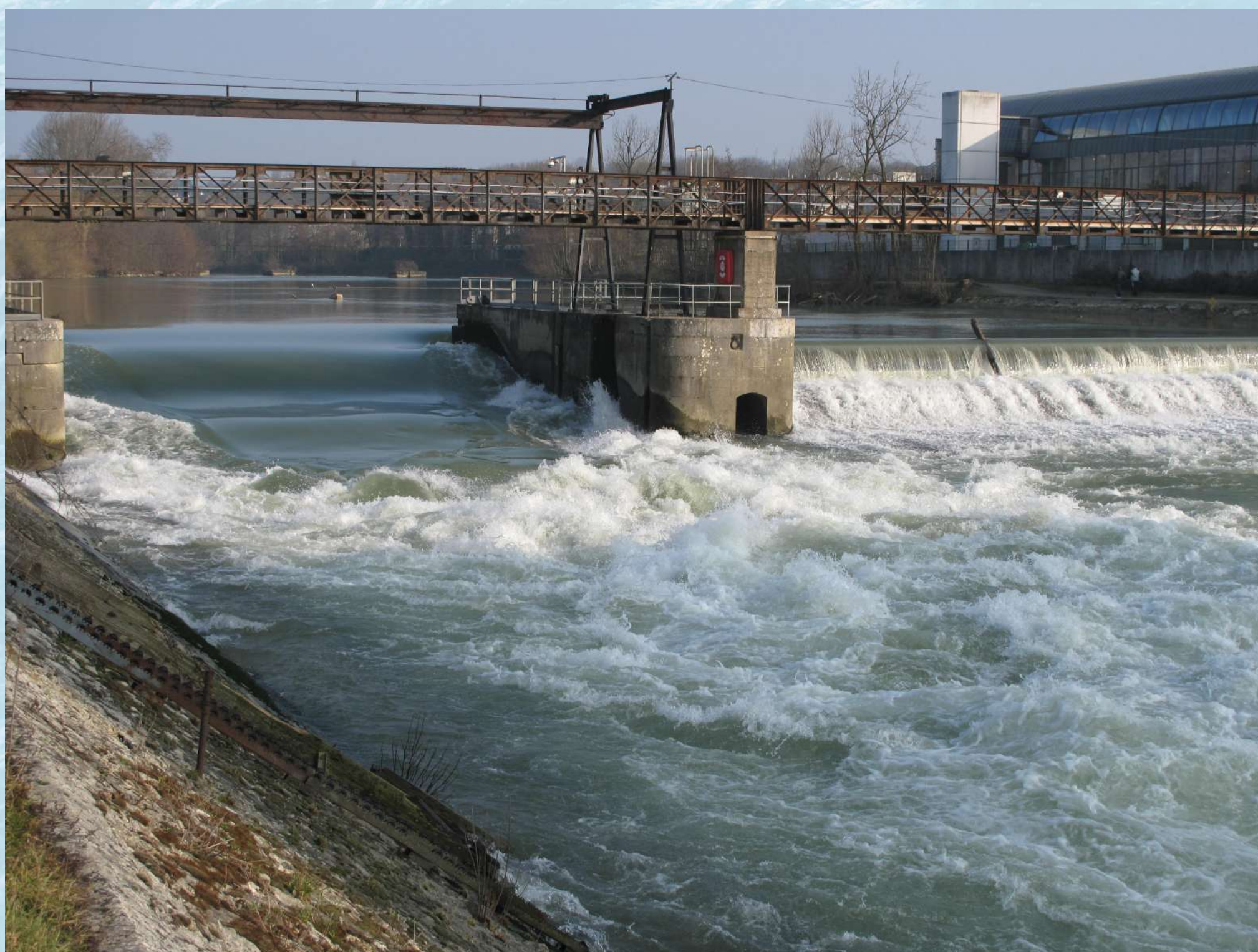
Transition entre écoulement laminaire et turbulent au barrage de Noisiel.
