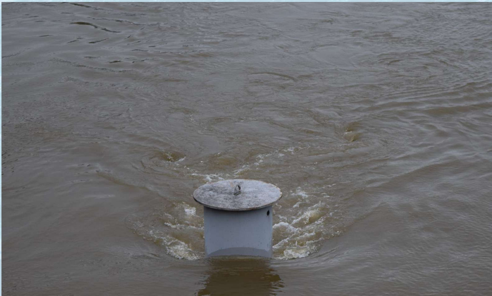
Plot d'amarrage dans la Seine en crue. De nombreux tourbillons sont présents, notamment dans le sillage de l'obstacle. © F. Lachaussée
