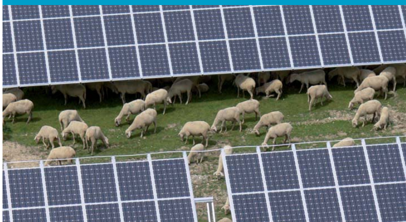
Parc solaire de 10 MWc installé à Pocking (Allemagne) capable d'alimenter 3 300 maisons en électricité.
